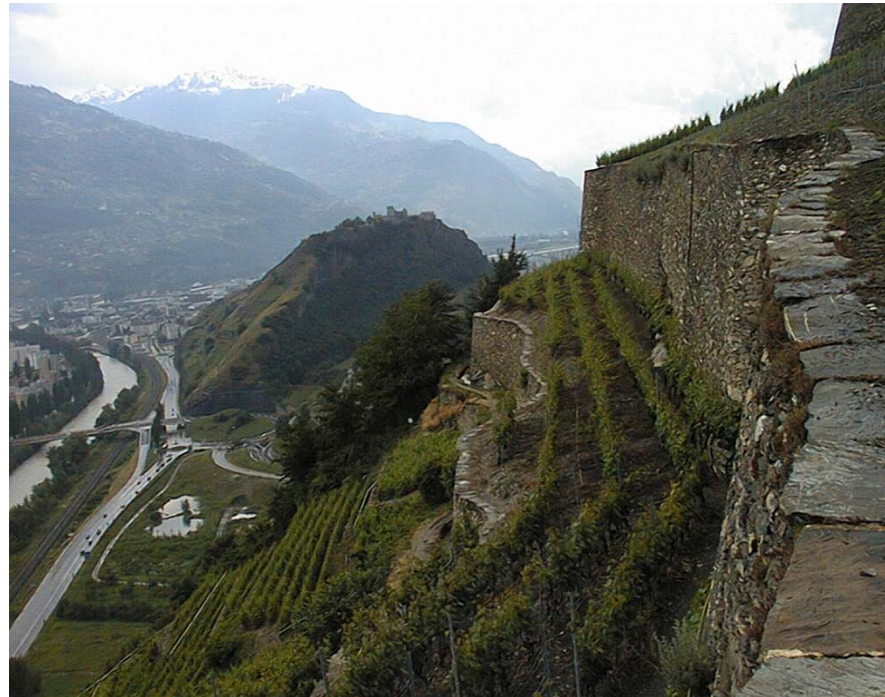
Trockensteinmauern an der Suone Clavau
